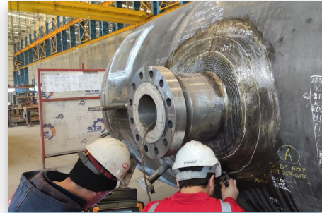
Inspection (NDT & ANDT)
